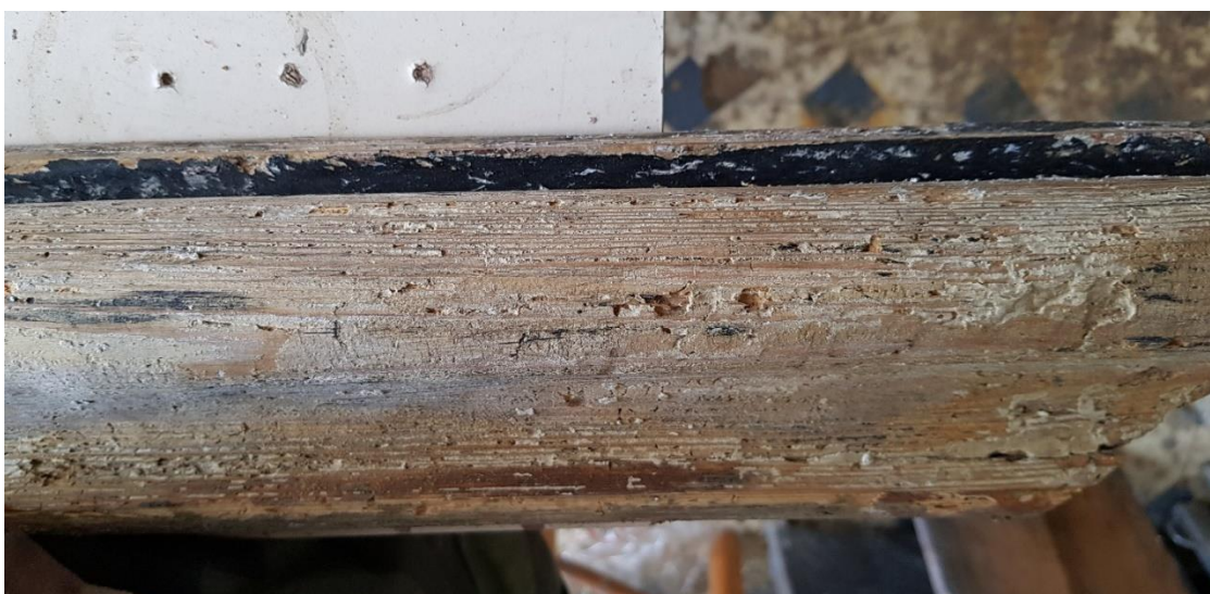
Fotografia 30 Fragment profilu ramy w trakcie usuwania przemalowań. Oryginalne opracowanie zachowane szczątkowo (resztki zaprawy kredowo-klejowej malowane czernią – warstwa zachowała się praktycznie jedynie w zagłębieniach), drewno silnie porażone przez owady.
