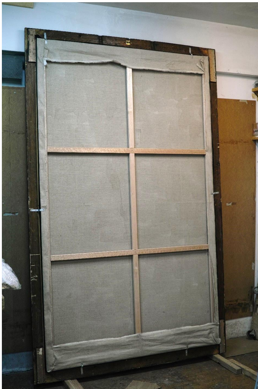
Fotografia 45 Jedna ze stacji – odwrocie – po zamocowaniu w ramie, po konserwacji i restauracji. Ramy dodatkowo od odwrocia mają założoną warstwę membrany paroizolacyjnej.
